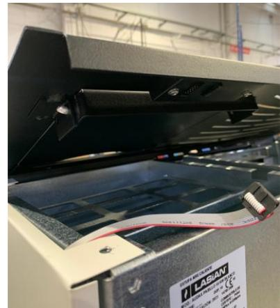
Retirar la “Chapa cierre salida extractor superior” (10437) desatornillando los 4 tornillos B y guardándolos para atornillar posteriormente el kit de canalización.
